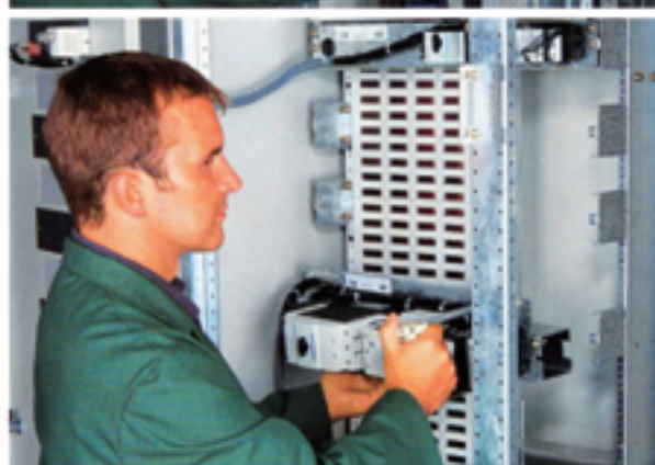
插接母线系统 导轨(短或长)在柜体 的左右侧
